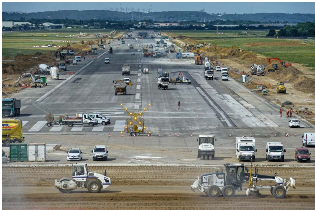
TRAVAUX DE LA PISTE 4 DE PARIS-ORLY, 2016
